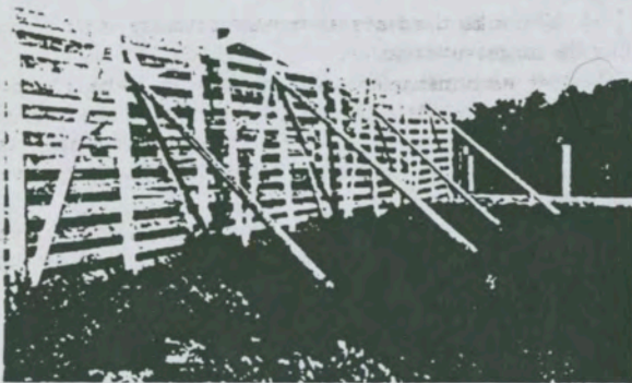
Fig. 228. Flyttbar snøskjerm fra Dovre—Hjerkinn. Avstivet med strevere og barduner til begge sider.
