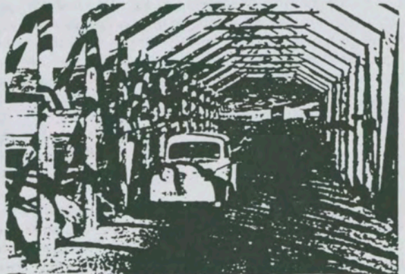
Fig. 232. Skjelett for snooverbygg. Hardangervidda.
