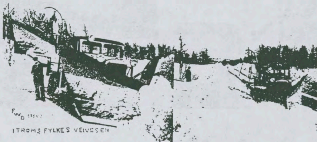
Fig. 212. Forplog og kantplog. Vegvesenet i Troms fylke. Kantplogen henger i en david.
