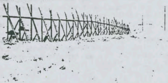
Fig. 231. Skjelett til fast snøskjerm på Hardangervidda.
